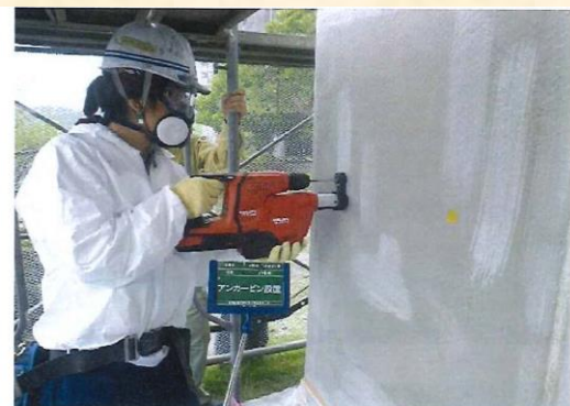
・アンカーピン穿孔作業状況
