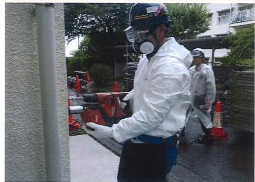
・壁つなぎ穿孔作業状況
