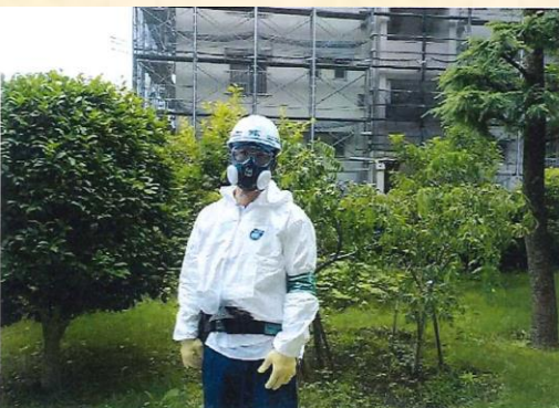
・石綿作業保護具着用（ピンネット工）
